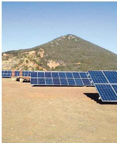
L'impianto fotovoltaico nell'area ex mineraria di Rio Marina
